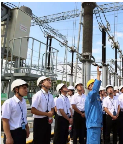
南方电网 江门高压站机房项目
