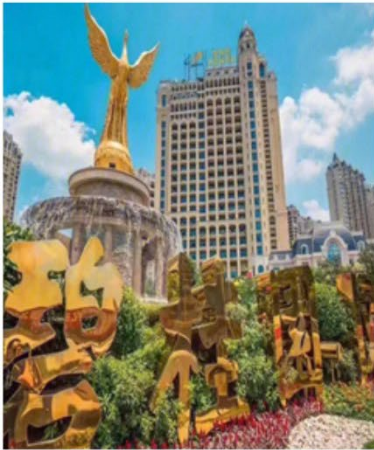
项目：增城碧桂园凤凰名苑（面积：60万m 2 ） 建设单位或施工单位：华西集团四川六建 所供项目：广羽桥架供货
