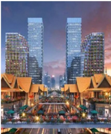
项目：云南融创孔雀小镇（总建筑面积：90万m 2 ） 施工单位：中瑞建设集团有限公司 所供项目：广羽桥架供货
