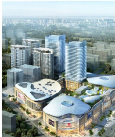
项目：佛山雄盛广场（总建筑面积：57万m 2 ） 建设单位或施工单位：广州际州信息科技有限公司 所供项目：广羽桥架供货
