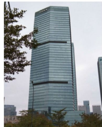
项目：深圳前海中海油大厦（高度：210米） 建设单位或施工单位：中铁二局 所供项目：广羽桥架供货
