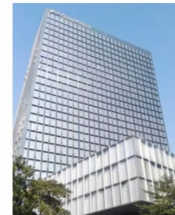
项目：深圳水贝珠宝大厦（高度：210米） 建设单位或施工单位：华西集团 所供项目：广羽桥架供货
