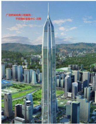
项目：平安国际金融中心北塔（高度：595米） 建设单位或施工单位：中建一局，捷星消防 所供项目：广羽桥架供货（亚洲最高楼）
