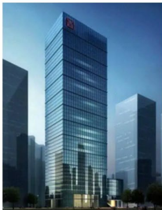
项目：深圳生命保险大厦（高度：248米） 建设单位或施工单位：中建四局 所供项目：广羽桥架供货
