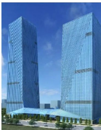
项目：腾讯数码大厦（高：210米，面积：230万m 2 ） 施工单位：中建安装/同方泰德 所供项目：广羽桥架供货
