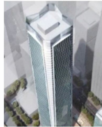
项目：深圳冠泽金融中心（高度：293米） 建设单位或施工单位：中国华西 所供项目：广羽桥架供货
